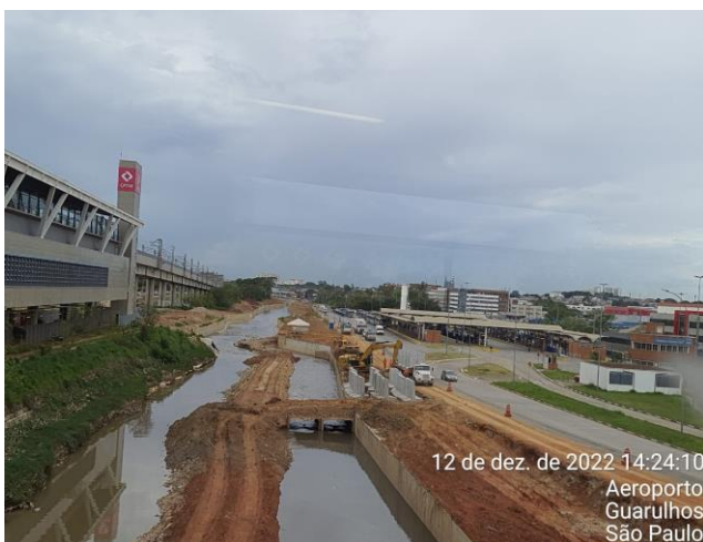
FOTO 6 – OPERAÇÃO COM INTERFERÊNCIA NA VIA
